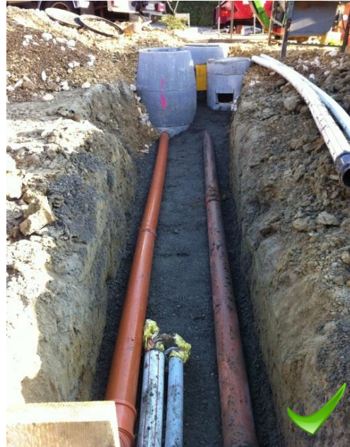
Canalisations AVEC assise bétonnée
