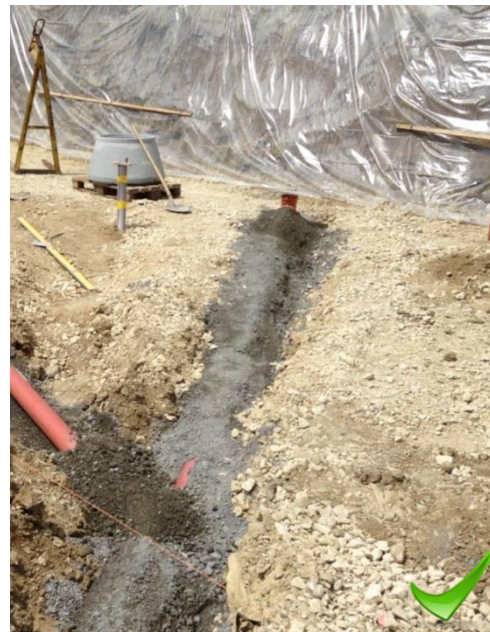
Canalisations en cours de bétonnage
